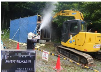
被災家屋等の解体の様子
