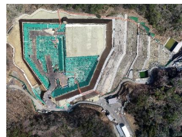
特定廃棄物埋立処分施設
