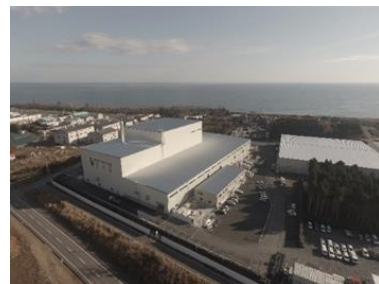
大熊町の仮設焼却施設
