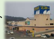
復旧後の外観
