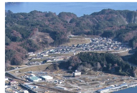
岩手県宮古市（田老地区）の高台移転
