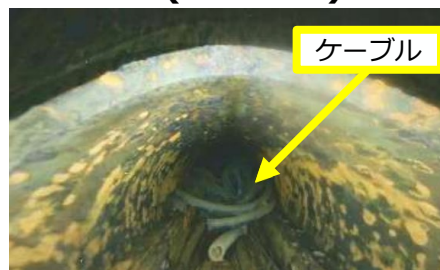
①PCV貫通部(X-6ペネ)内の様子
