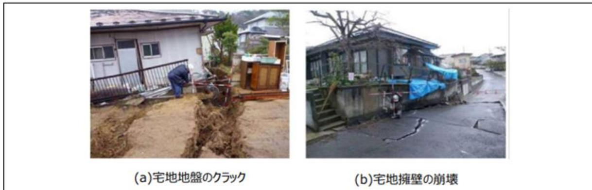
出所) 国土交通省「大規模盛土造成地の滑動崩落対策について 3. 過去の被害事例 (4) 2011年 東北地方太平洋沖地震の事例 (谷埋め型大規模盛土造成地)
