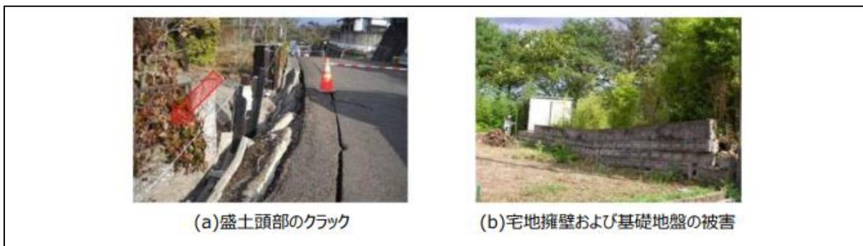
出所) 国土交通省「大規模盛土造成地の滑動崩落対策について 3. 過去の被害事例 (4) 2011年 東北地方太平洋沖地震の事例 (谷埋め型大規模盛土造成地)
