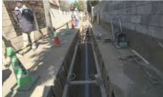
下水道管渠整備
