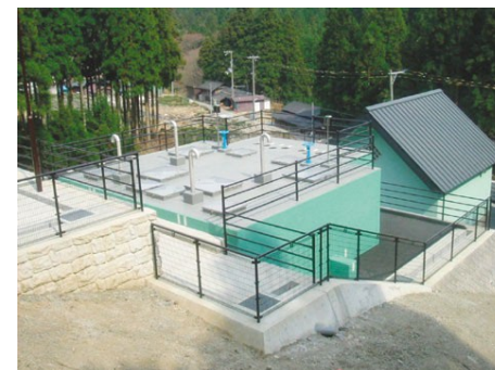
【簡易水道の整備】
