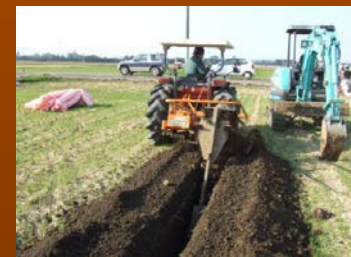
暗渠排水の設置
