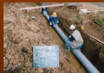
農業用水路の設置
