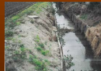
老朽水路の改修
