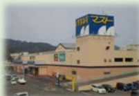
復旧後の外観
