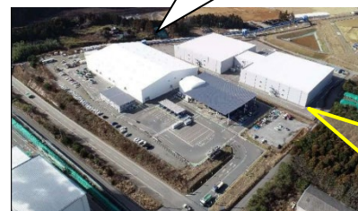
受入・分別施設 外観(大熊町)
