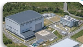
楢葉遠隔技術開発センター
