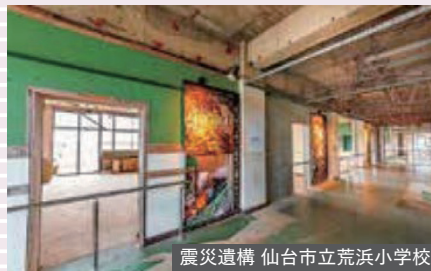
震災遺構 仙台市立荒浜小学校
