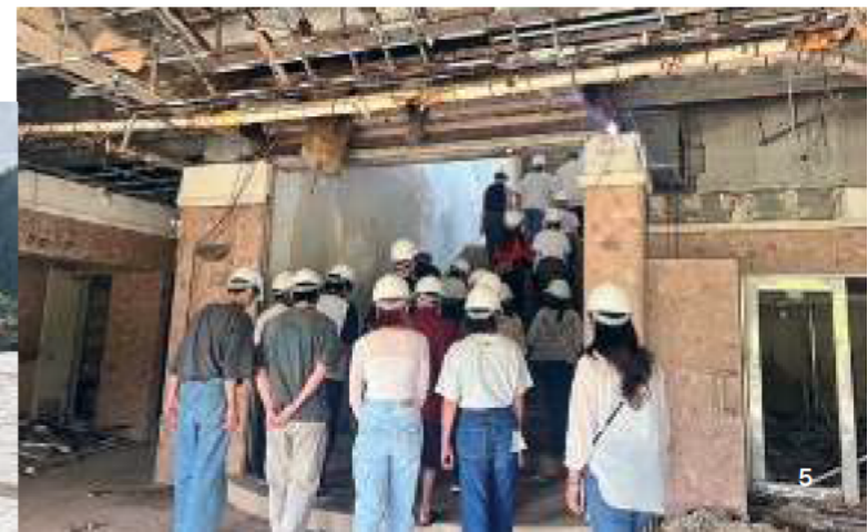
津波にのまれた「高野会館」へ。
