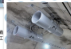
トンネル内の換気設備「ジェットファン」の設置工事も行っています
