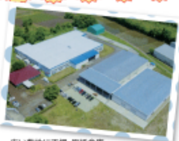
広い敷地に工場、原紙倉庫、 製品倉庫が並んでいます
