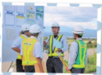
会津坂下町での震災災害復興工事の現場。台風によって崩れた崖を修復しています
