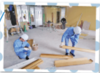
隊員の3人も実際の工事現場を見学し、作業を体験
