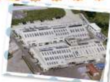
合津の地で鋳造事業の基盤をつくる
