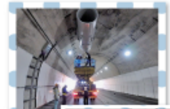
トンネル内の換気設備「ジェットファン」の設置工事も行っています
