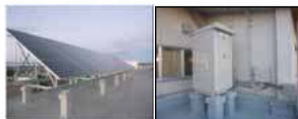
2011～2015 市市中核避難所に整備した PVと蓄電池 (GND)
