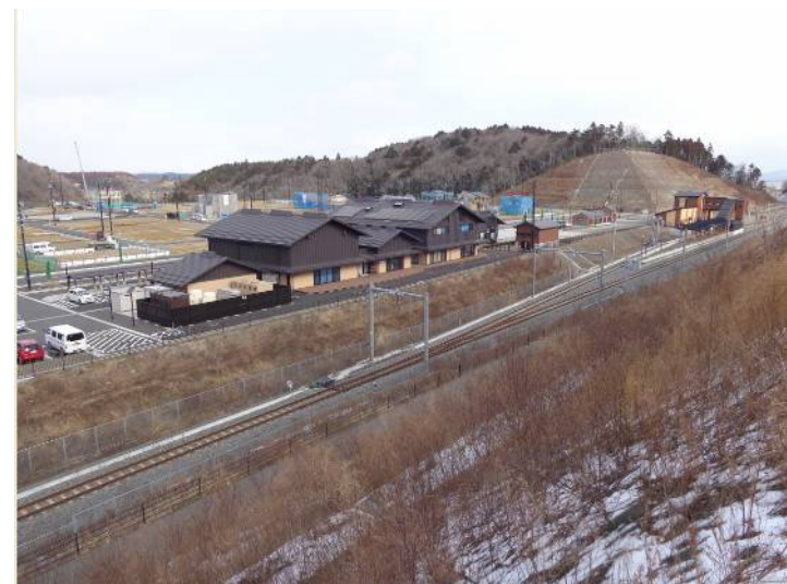
②東工区(金山⇒館跡付近方面)
