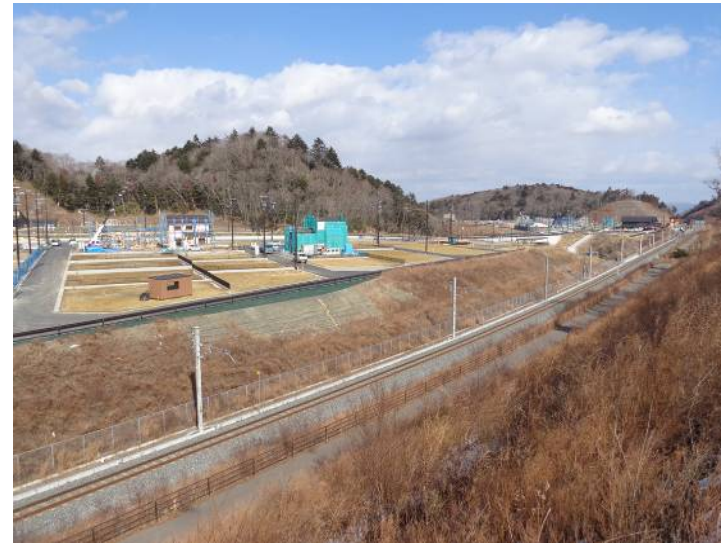
④中工区(新山⇒金山方面)
