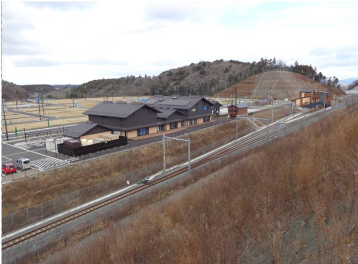
②東工区(金山⇒館跡付近方面)
