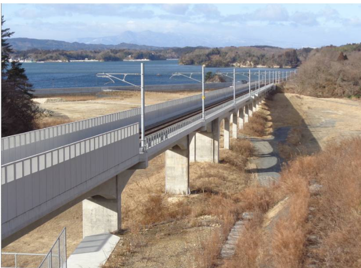
⑨西工区(鷹打山⇒松島方面)
