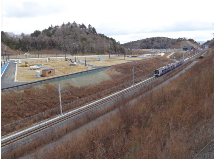
④中工区(新山⇒金山方面)
