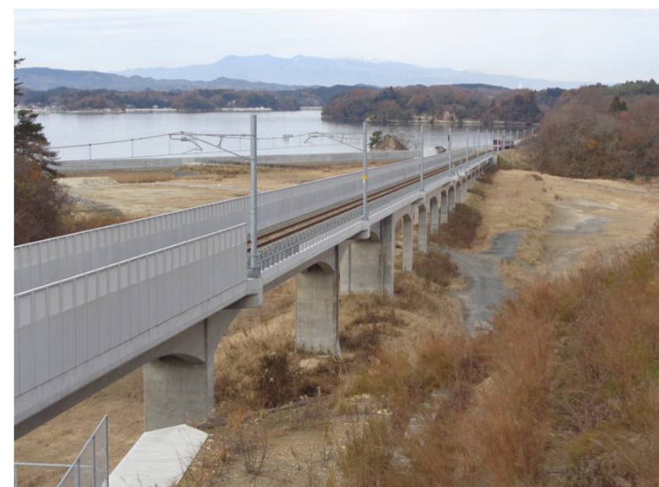
⑨西工区(鷹打山⇒松島方面)
