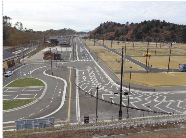
①東工区(館跡付近⇒金山方面)
