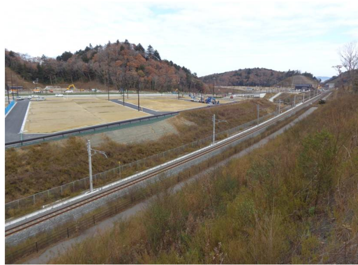
④中工区(新山⇒金山方面)
