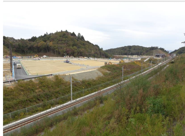
④中工区(新山⇒金山方面)
