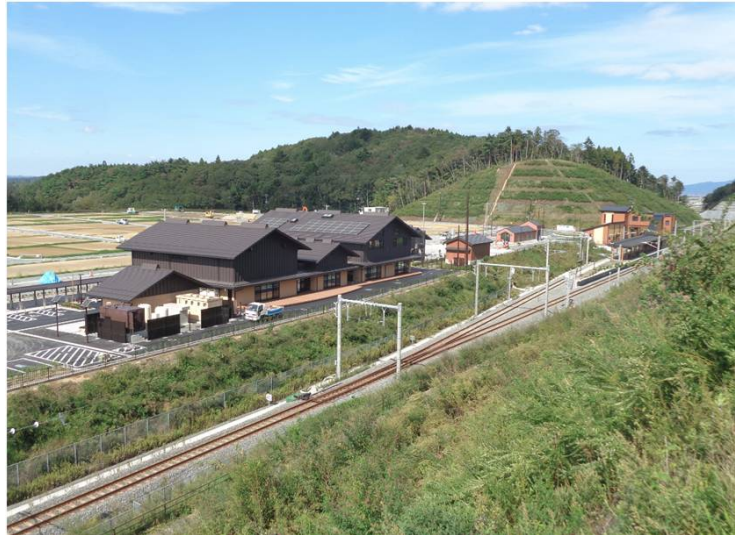
②東工区(金山⇒館跡付近方面)
