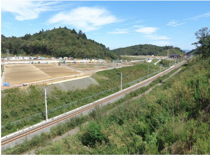
④中工区(新山⇒金山方面)
