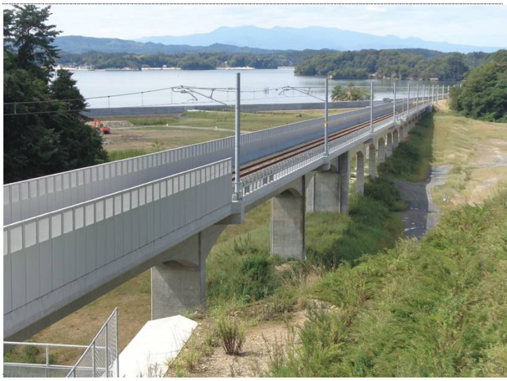
⑨西工区(鷹打山⇒松島方面)
