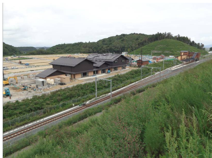
②東工区(金山⇒館跡付近方面)
