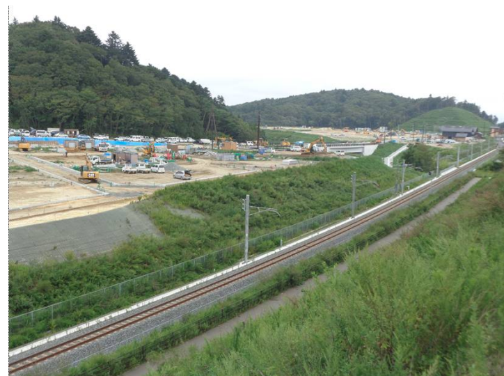
④中工区(新山⇒金山方面)
