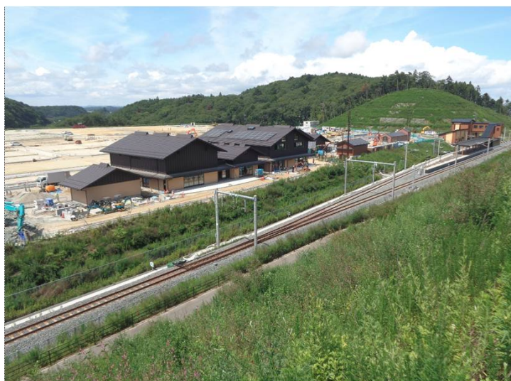
②東工区(金山⇒館跡付近方面)
