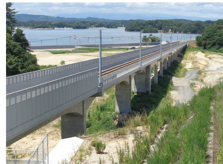
⑨西工区(鷹打山⇒松島方面)
