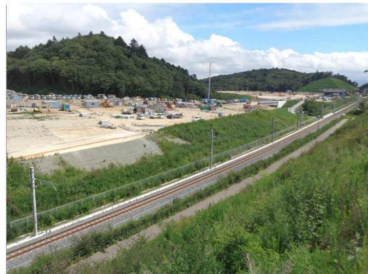
④中工区(新山⇒金山方面)
