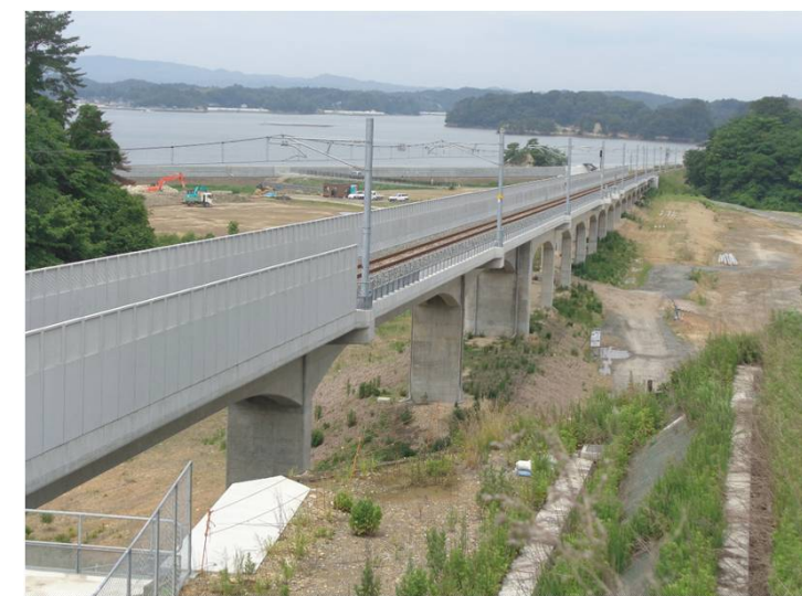
⑨西工区(鷹打山⇒松島方面)
