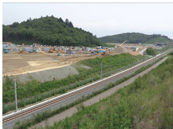
④中工区(新山⇒金山方面)
