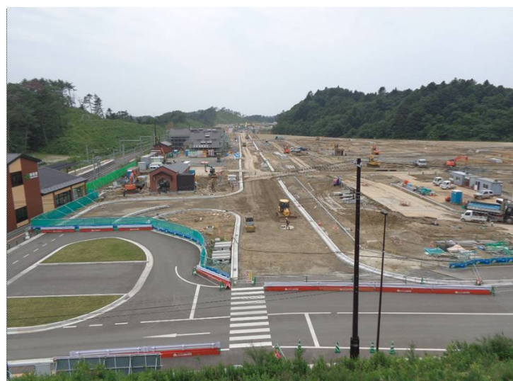
①東工区(館跡付近⇒金山方面)
