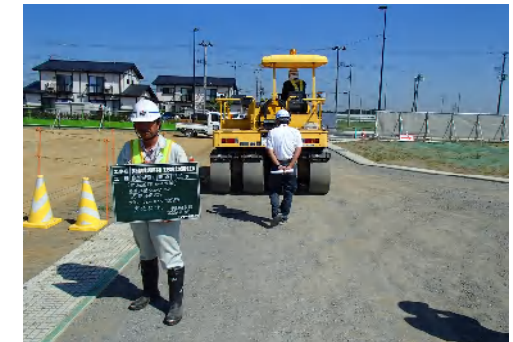
写真④ 東松島市建設課 プルフローリング試験状況
