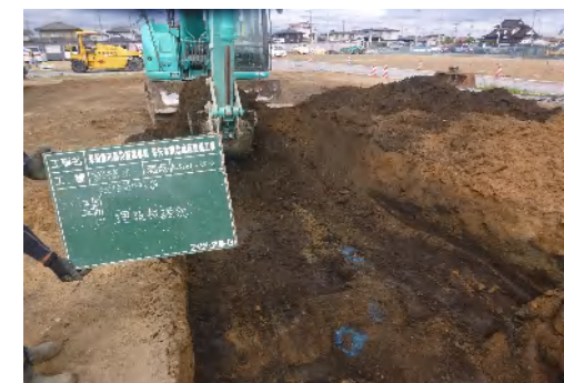
写真⑤ 3-2工区 従前畑地部 試掘状況
