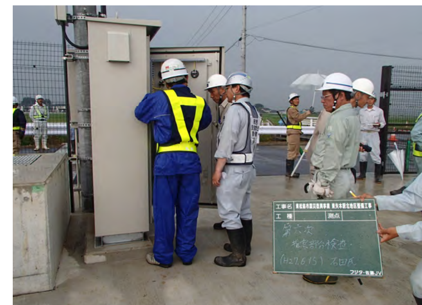
写真⑤ 第6次指定部分検査状況
