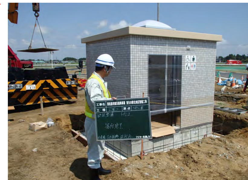
写真④ 3号公園 トイレ設置
