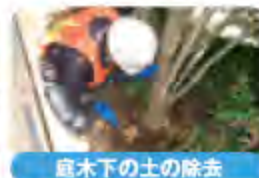
庇木下の土の除去
