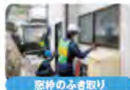
窓枠のふき取り
