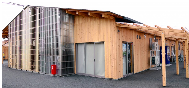
写真：「美人杉」を使用して設計された商店街施設
