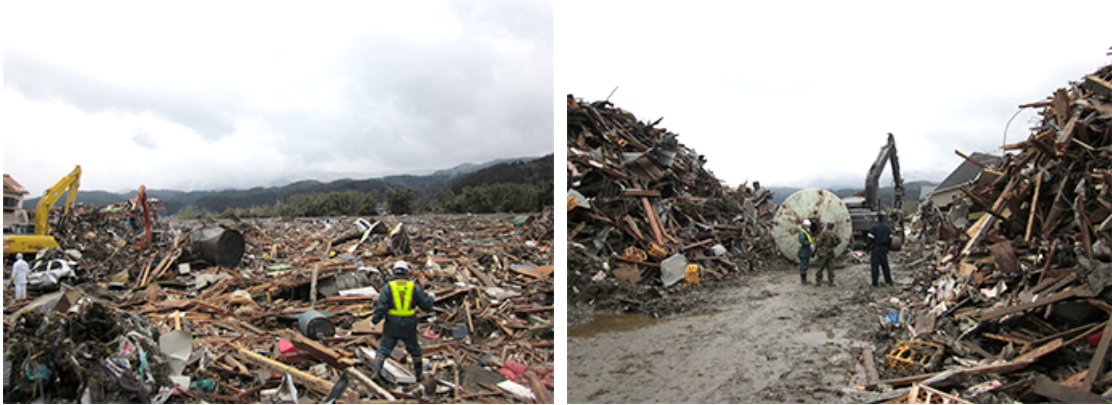
写真1：陸前高田市内の道路啓開（左：啓開前、右：啓開後）（出典：国土交通省 東北地方整備局）
