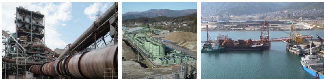
写真：被災を免れた5号キルン（左）、設置した除塩設備（中）、船による広域受入れ（右）
