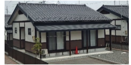
相馬市細田東団地災害公営住宅 （復興庁撮影2022.5.12）
