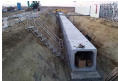
石巻市 新門脇地区 下水道雨水災害復旧事業
