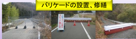
バリケードの設置、修繕
