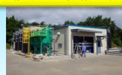
排水処理設備の管理
