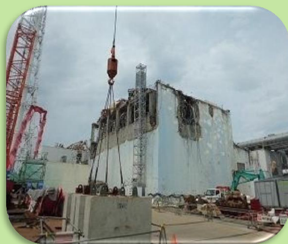
ガレキ撤去、除染
