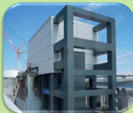
取り出しカバー設置
