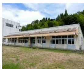
既存施設を改修し整備予定
