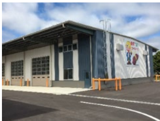
令和2年度に交付金を活用して整備した甘藷貯蔵施設
