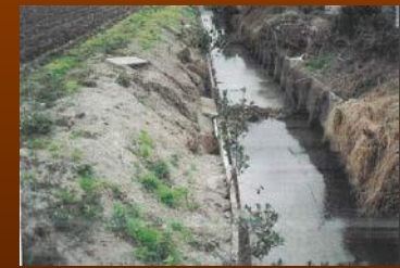
老朽水路の改修
