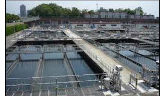
下水道処理場の整備
