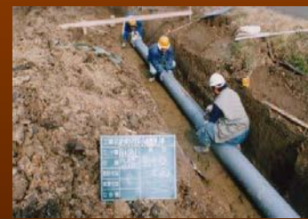
農業用水路の設置
