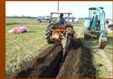
暗渠排水の設置
