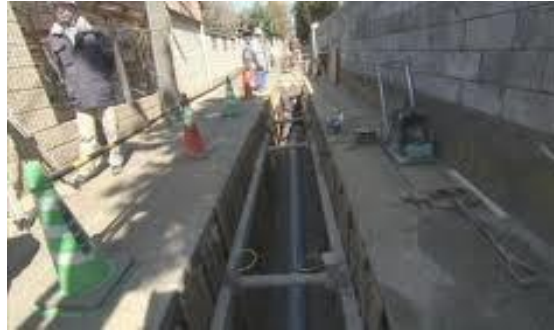
下水道管渠整備
