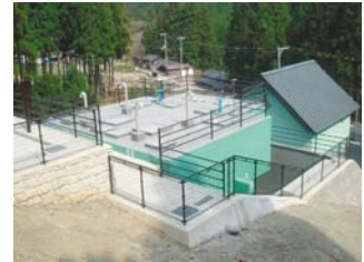
【簡易水道の整備】
