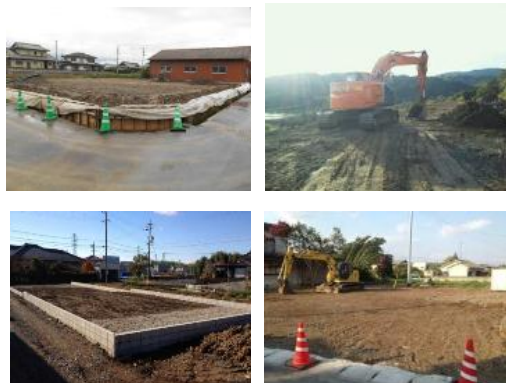
【土地造成現場の例】
