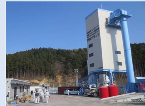
宮城県(気仙沼) 仮設プラント
