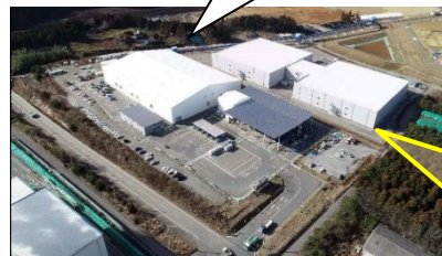
受入・分別施設 外観(大熊町)
