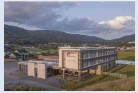
宿泊施設外観 (陸前高田市)
