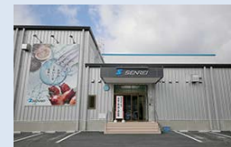
水産加工場外観(女川町)
