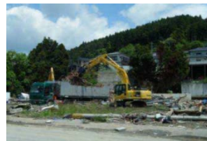
【被災家屋の解体・撤去】
