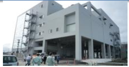
製氷・貯氷施設(宮城県気仙沼市) 平成24年3月交付決定。 平成24年10月中旬から稼働開始。
