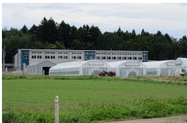
ハウス、集出荷複合施設
