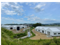
かんしょ高品質苗供給施設（楡葉町）
