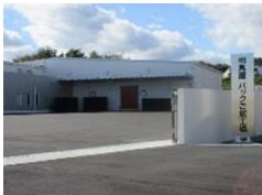
令和5年11月に竣工したパックご飯工場（楡葉町）
