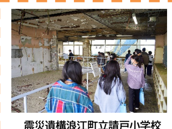
震災遺構浪江町立請戸小学校
