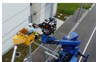
先端ロボットによる実証試験
