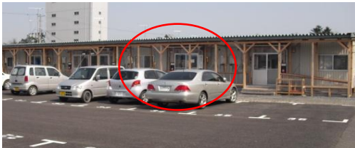
事務室は仮設住宅の空き室 (鳴瀬被災者サポートセンター)
