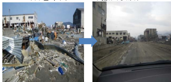
(石巻市内のガレキ撤去状況)
