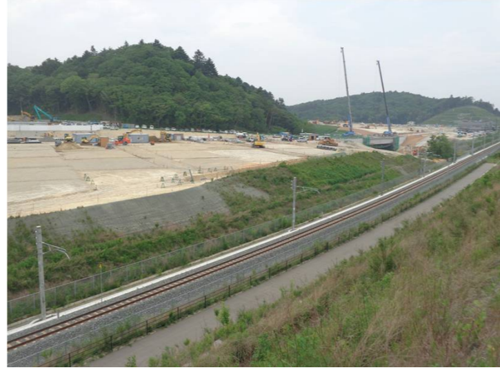
④中工区(新山⇒金山方面)
