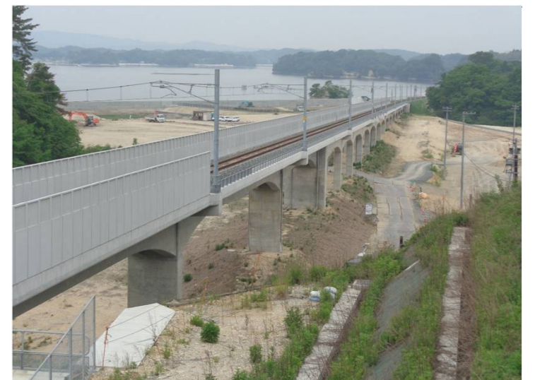
⑨西工区(鷹打山⇒松島方面)
