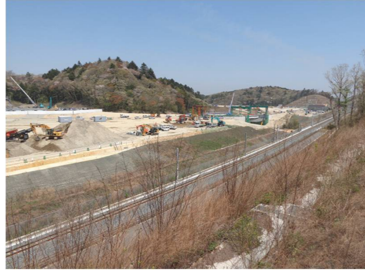
④中工区(新山⇒金山方面)
