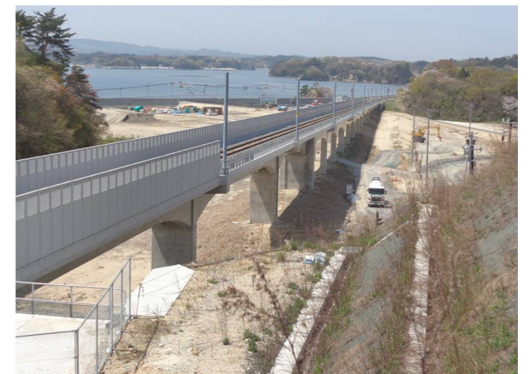
⑨西工区(鷹打山⇒松島方面)
