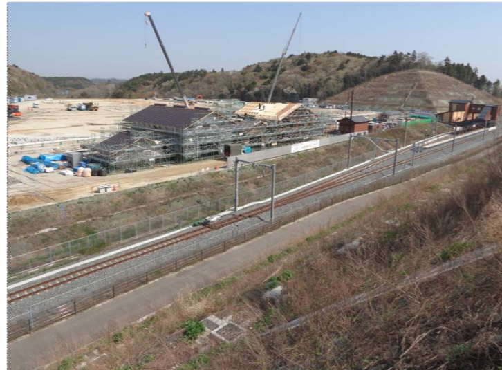
②東工区(金山⇒館跡付近方面)
