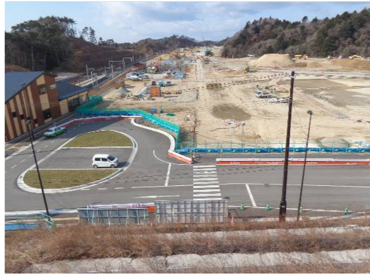
①東工区(館跡付近⇒金山方面)
