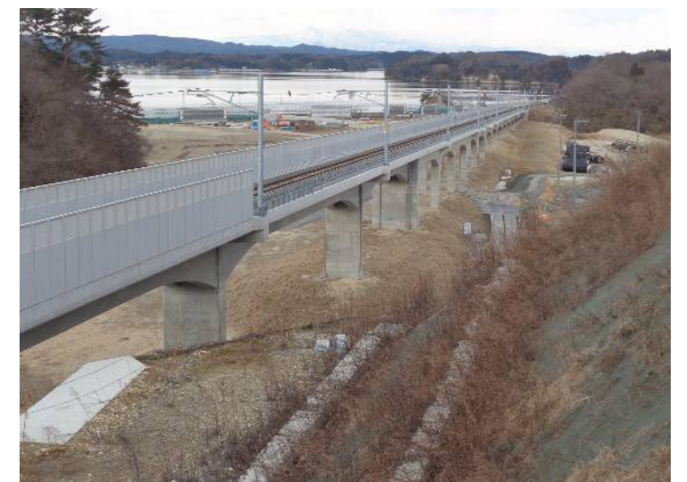
⑨西工区(鷹打山⇒松島方面)
