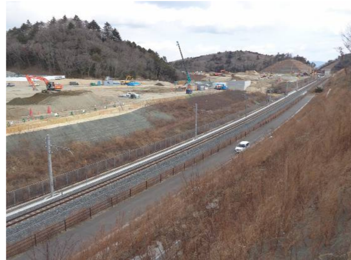
④中工区(新山⇒金山方面)
