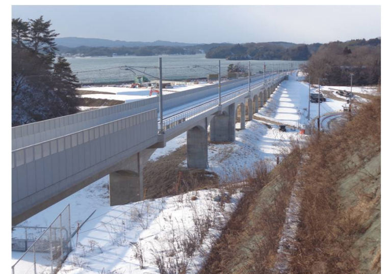
⑨西工区(鷹打山⇒松島方面)
