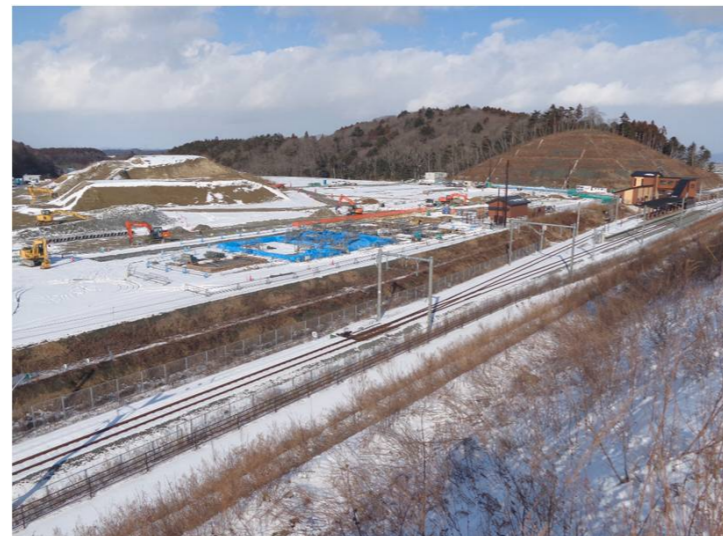
②東工区(金山⇒館跡付近方面)
