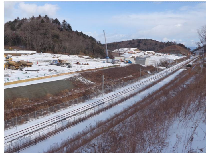
④中工区(新山⇒金山方面)
