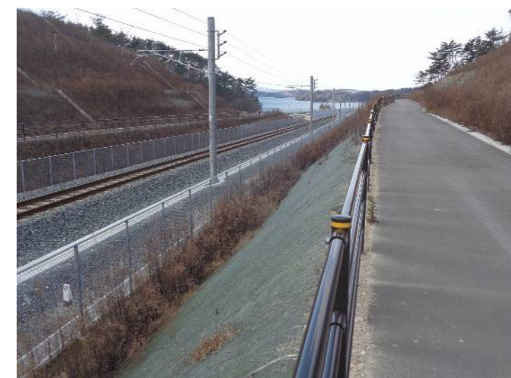
⑨西工区(鷹打山⇒松島方面)
