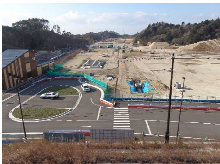
①東工区(館跡付近⇒金山方面)
